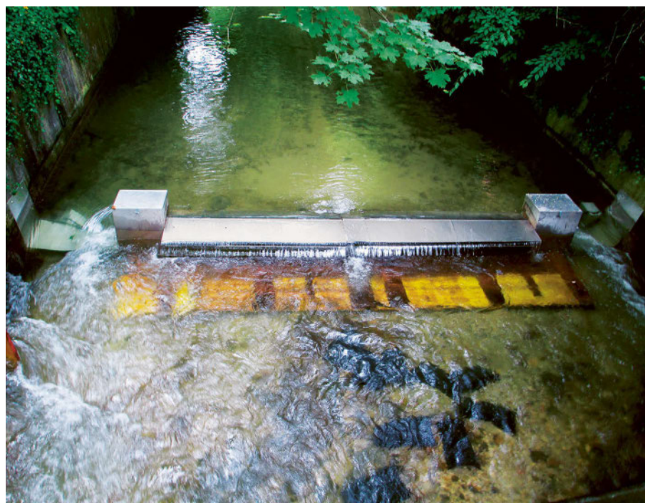
Installation expérimentale d'une barrière à écrevisses dans un canal à Münchenstein (BL). Le courant rapide doit empêcher les écrevisses de franchir l'échelle à poissons à droite et à gauche de la barrière.
