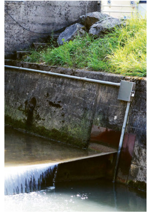
Barrière à écrevisses formée par une bande d'acier saillant.
